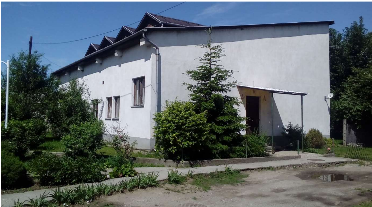
Putnok „családcsoportos” részleg épülete
