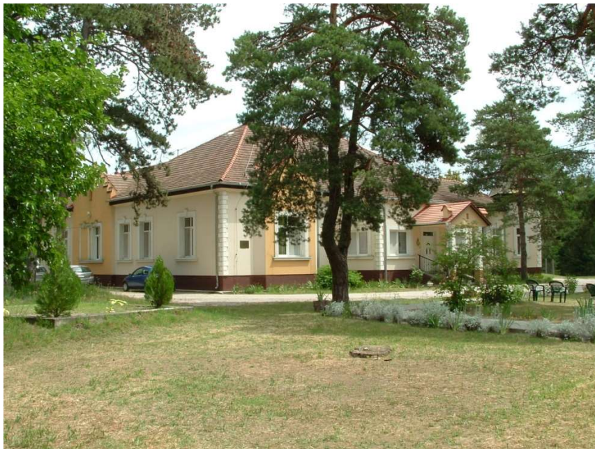
A kastély épülete
